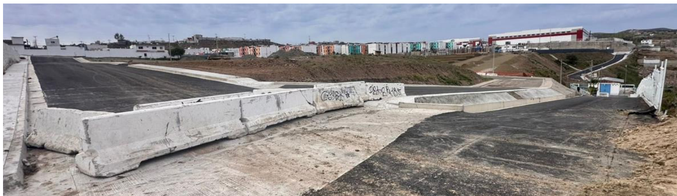
Fraccionamientos autorizados entre ductos y aguas negras.
